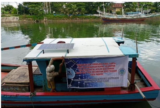
Gambar 5. Pemasangan Panel Surya Pada Kapal
