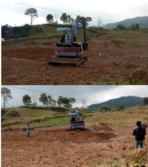
Gambar 8. Kegiatan meratakan tanah bekas tambang pasir Sumber: dokumentasi pribadi
