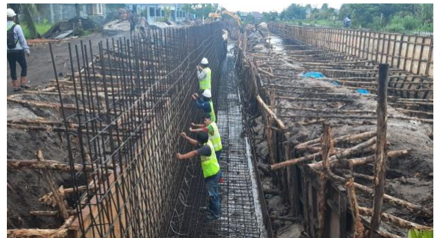
Gambar 3. Pekerjaan Pembesian Lantai Kerja Pembangunan Drainase Induk Kota Palangka Raya
