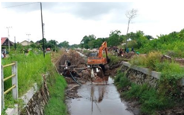
Gambar 2. Pekerjaan Galian Pembangunan Drainase Induk Kota Palangka Raya
