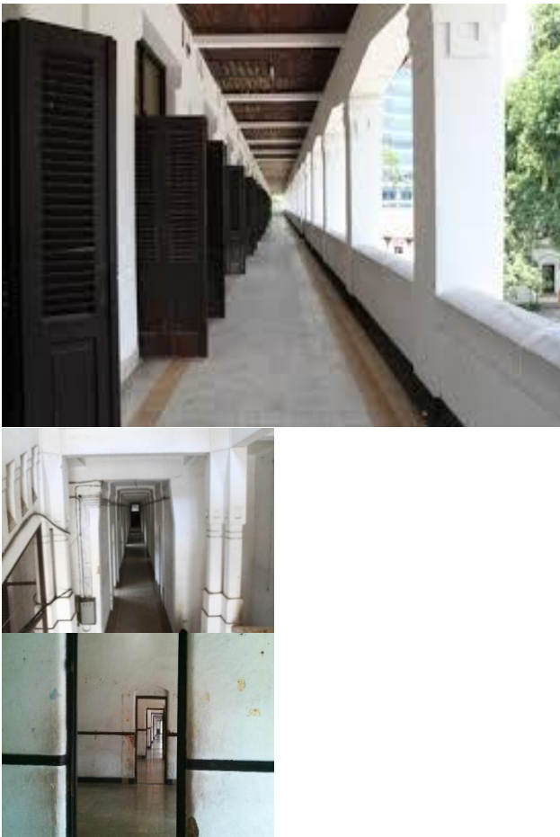
Gambar 2. Ragam bentuk dan pola sirkulasi di dalam dan luar bangunan/lorong : selasar disekeliling bangunan (atas) dan Lorong yang terletak di tengah bangunan (bawah) (Seputar-Semarang, 2013)
