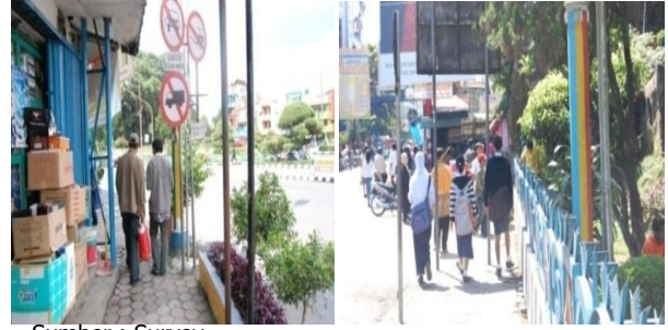
Sumber : Survey Gambar 38. Letak dan Dimensi Tiang Sign /Rambu Lalu Lintas
