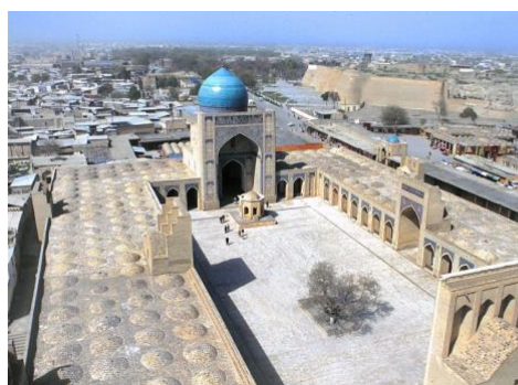
Gambar 6. Masjid Tipe Persia: Masjid Kalan di Bukhara, Uzbekistan. Meskipun iwan sisi Mekah diatapi dengan kubah simbolis, ukurannya tidak begitu besar seperti masjid tipe Turki, menutupi seluruh aula ibadah. (Dari Henri Stierlin, Arsitektur de l'Islam , 1979) (Sumber: Takeo Kamia, 2006)
