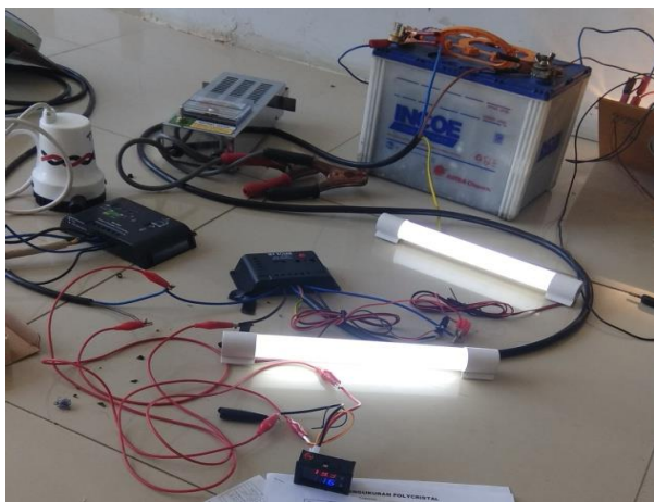
Gambar 15. Pengecekan kondisi BCC dan baterai
