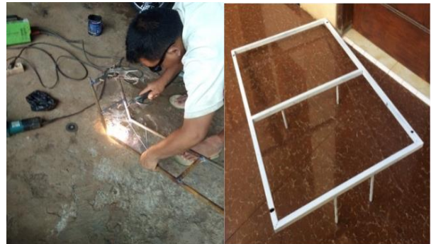
Gambar 12. Rangka dudukan panel surya
