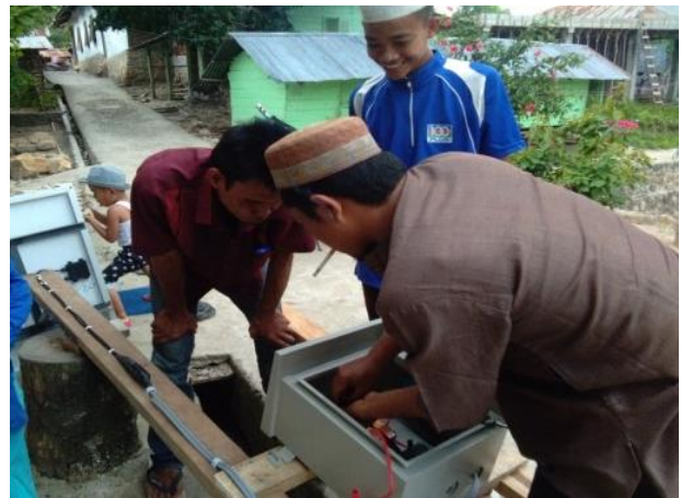
Gambar 5. Pemasangan Komponen Alat Panel Surya
