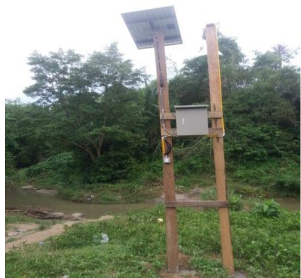
Gambar 6. Penerangan lampu jalan dari Panel Surya yang telah terpasang
