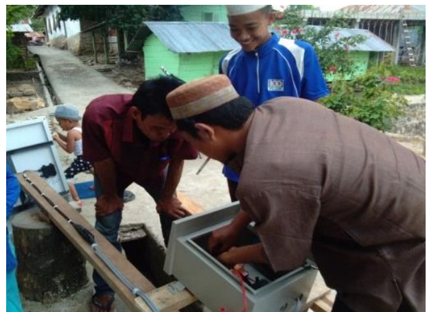
Gambar 5. Pemasangan Komponen Alat Panel Surya
