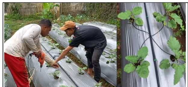
Gambar 4. Pemasangan pipa utama dan pipa kapiler: (a) pelubangan pipa utama untuk memasukkan emitter ke pipa utama; (b) Penampakan tanaman pada irigasi tetes
