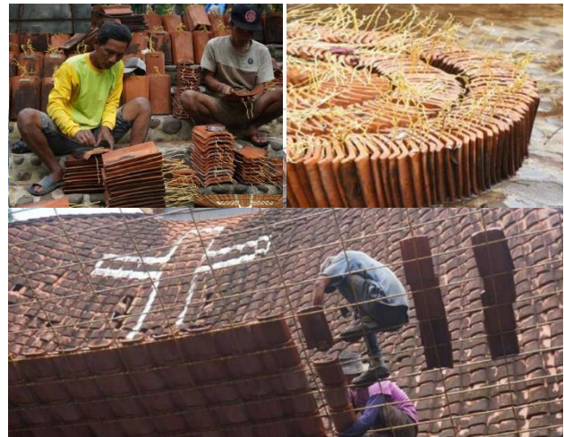
Gambar 16. Pemasangan Genteng pada Rangka Atap Naungan (Sumber: Penulis, 2025)
