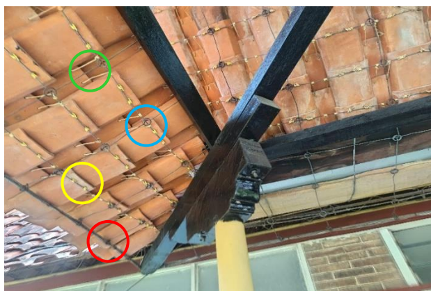
Gambar 11. Gordin, Usuk dan Reng Naungan Atap Gereja Puhsarang Pada Awal Pembangunan 1936 (Sumber: Penulis, 2025)
