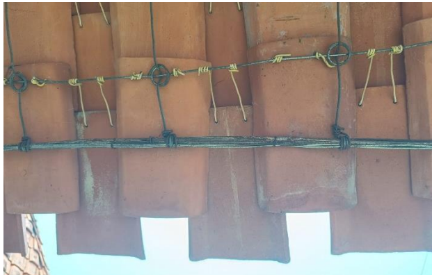
Gambar 15. Struktur Sambungan Penutup Atap dengan Rangka Atap Gereja Puhsarang (Sumber: Penulis, 2025)
