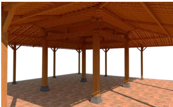
Gambar 6. Pondasi bangunan pokok Joglo dan Tajug yang menggunakan umpak (Sumber: Penulis, 2023)
