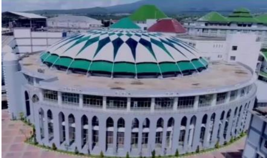
Gambar 5 Studi Banding Gedung Bundar Al – Asy'ari Universitas Islam Malang (Sumber: Ulul Azmi & Winaktu, 2023)
