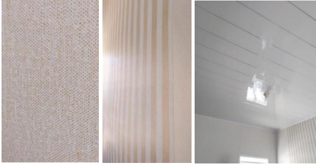
Gambar 13. Wallpaper Penutup Dinding dan Plafond PVC (Sumber : Penulis, 2022)
