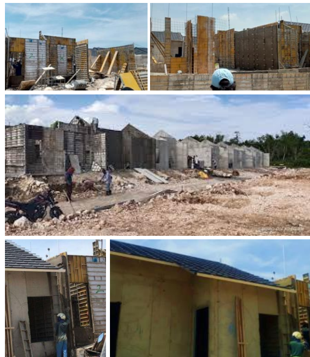
Gambar 8. Inovasi Sistem Struktur dan Konstruksi Menggunakan Metode Site Cast (Sumber : Penulis, 2022)
