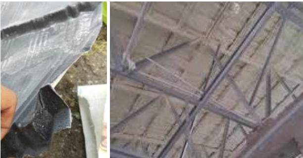
Gambar 6. Material Peredam Panas pada Atap (Sumber : Penulis, 2022)
