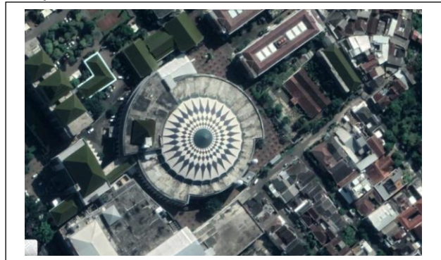
Gambar 1. Tampak Atas Gedung Bundar Al – Asy'ari
