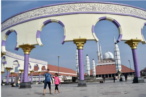
Gambar 3. Pilar-pilar MAJT Bergaya Romawi (Sumber: Redaksi, 2020)
