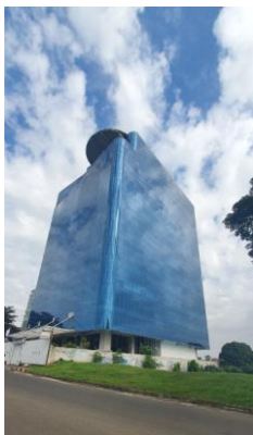
Gambar 1. Bangunan yang memakai curtain wall tanpa elemen peneduh (Sumber: Penulis, 2020)
