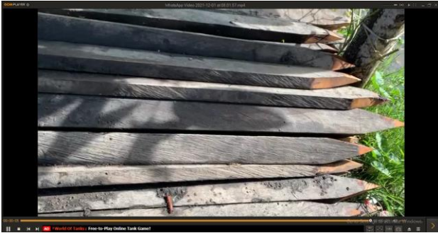
Gambar 12. Penanaman kayu sebagai pondasi
