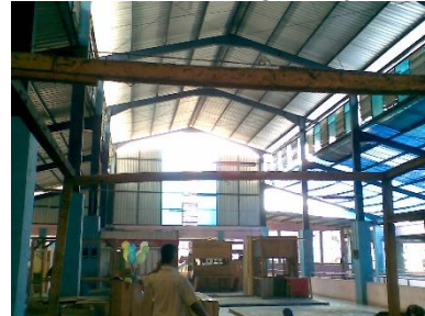
Gambar 13. Atap asbes
