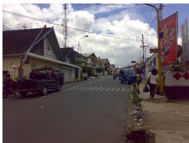
Gambar 7. Jalan di kampung Betengsari
