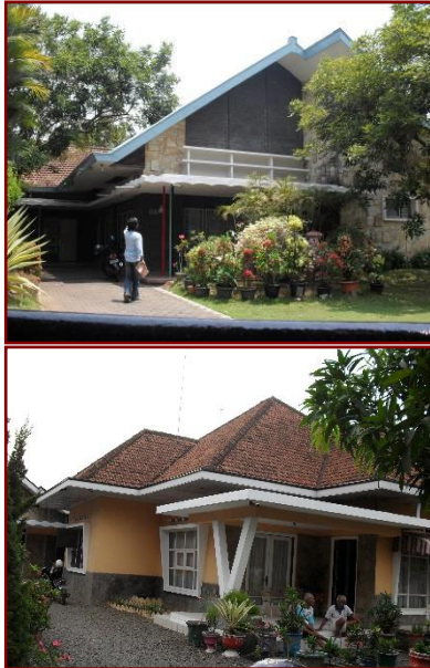
Gambar 1. Rumah Jengki Pekajangan. (Foto : Ardiyan Adhi, 2009)
