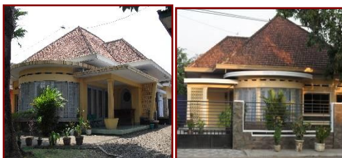
Gambar 6. Kaca jendela silindris pada rumah jengki Pekajangan (Foto : Ardiyan Adhi, 2009)
