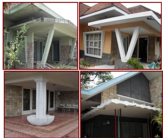
Gambar 4. Bentuk-bentuk tiang penyangga pembentuk portico rumah jengki Pekajangan (Foto : Ardiyan Adhi, 2009)
