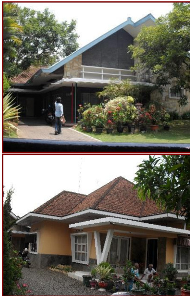
Gambar 1. Rumah Jengki Pekajangan. (Foto : Ardiyan Adhi, 2009)
