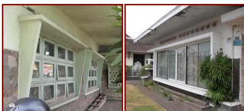
Gambar 5. Lis berbentuk dinding miring dan kubistik yang mengelilingi jendela pada rumah jengki Pekajangan (Foto : Ardiyan Adhi, 2009)
