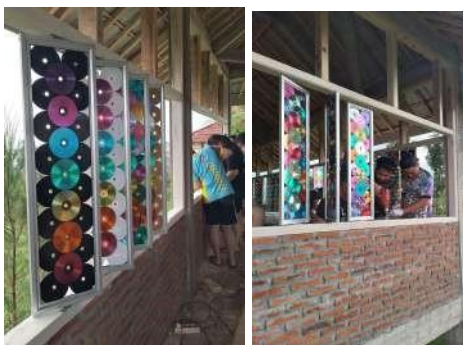
Gambar 13. Pemasangan modul kinetik limbah CD di lapangan (Sumber: Dokumentasi Penulis, 2023)
