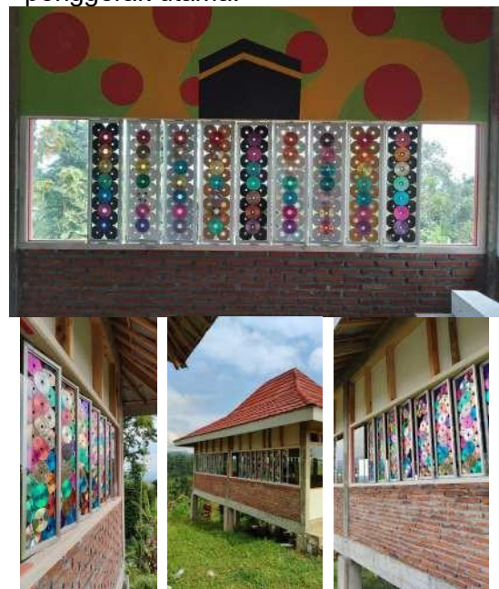
Gambar 14. Modul fasad kinetik dari limbah CD yang telah terpasang (Sumber: Dokumentasi Penulis, 2023)
