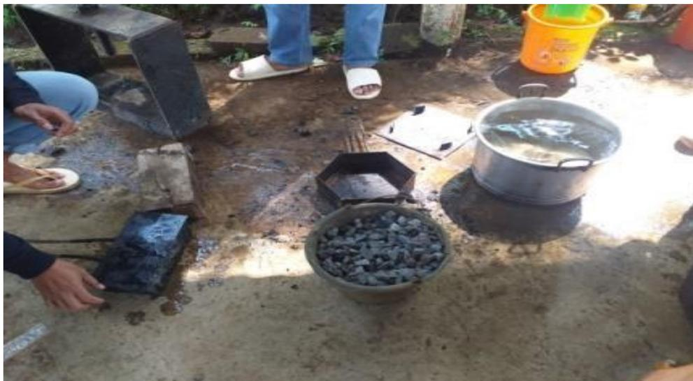
**Gambar 4. Melepaskan Paving Block dari Cetakan**
