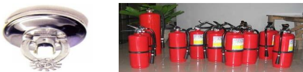
Gambar 4.38. Sprinkler Dan Tabung Pemadam Kebakaran (Sumber : Data Primer Peneliti )
