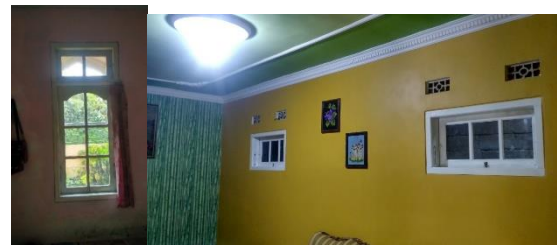
Gambar 12. Ventilasi kamar dan Ruang Keluarga
