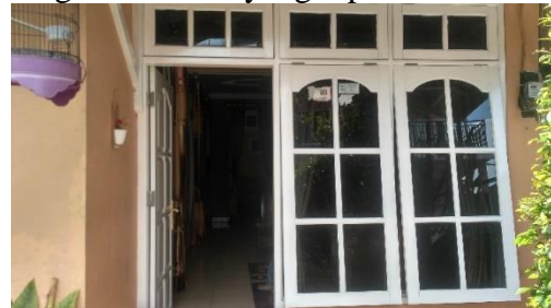
Gambar 8. Tampak Depan Rumah
