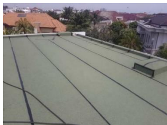
Gambar 3.22 Atap Dak Beton
