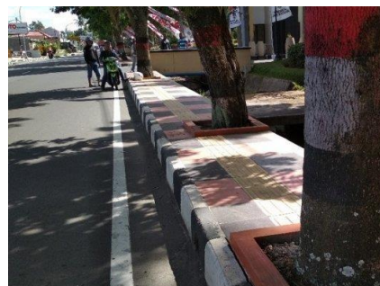
Gambar 3. kondisi dimana trotoar terputus oleh pepohonan dan membahayakan Sumber.Dokumentasi
