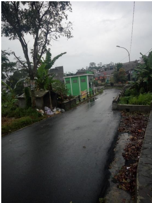
Gambar 7. Kondisi jalanan yang harus ditambah penerangan.
