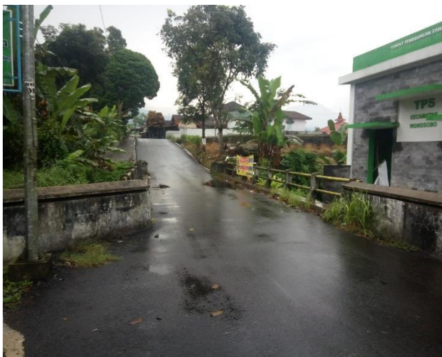
Gambar 8. Kondisi jalanan yang harus ditambah penerangan.
