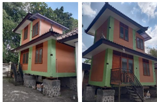
Gambar 15. RUSPIN tipe 27 dengan Prototipe RBI terpasang sebagai sistem base isolation (BLPW II, 2019)
