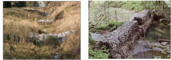
Gambar 8. Desain Cekdam Sederhana dengan Material Bronjong
